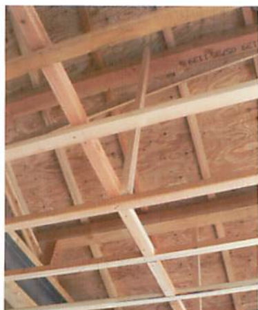
図6 天井の吊り木
