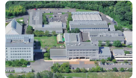
近畿職業能力開発大学校(大阪府岸和田市)
