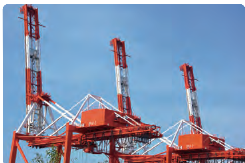
ガントリークレーン
