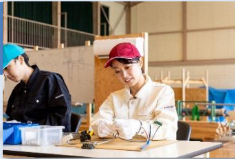
電気工事単位作業
