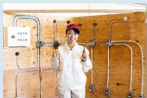
現場を想定した配線工事
