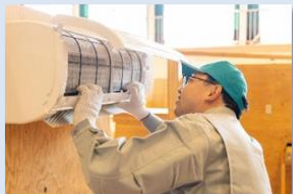
エアコン(空調設備)工事
