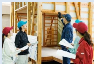
木造住宅の外装内装工事
