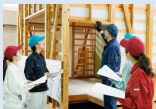
木造住宅の外装内装工事
