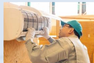
エアコン(空調設備)工事
