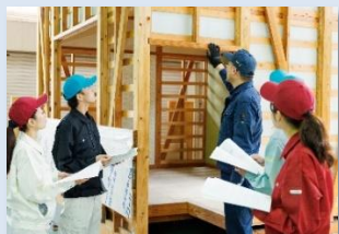
木造住宅の外装内装工事
