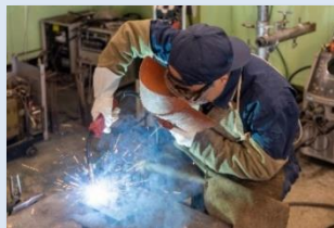
被覆アーク溶接
