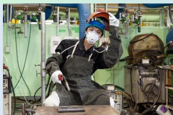
ガス溶接・炭酸ガスアーク溶接
