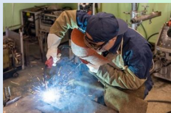
被覆アーク溶接
