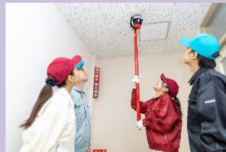
消防設備・ 構造物運搬
