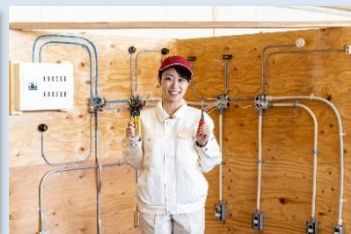
現場を想定した配線工事
