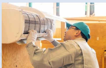
エアコン(空調設備)工事
