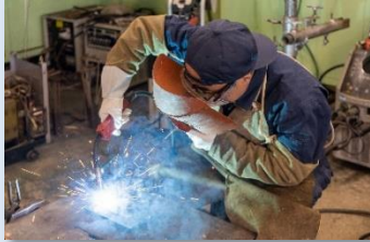
被覆アーク溶接
