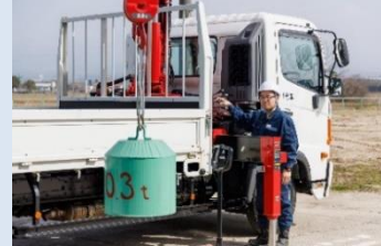
クレーン・玉掛け作業
