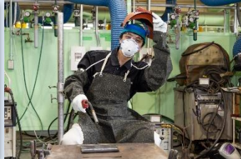
ガス溶接・炭酸ガスアーク溶接
