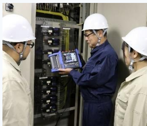
▲ 電気設備のトラブル対策実習
