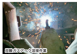
炭酸ガスアーク溶接作業
