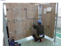
金属管、合成樹脂管、可とう電線管、金属線び、リモコンの配線工事等に関する技能を習得します。
