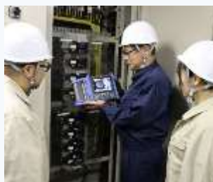
▲ 電気設備のトラブル対策実習
