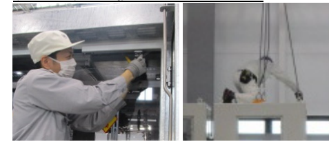
▲配電盤を製作する修了生
