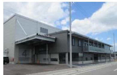
▲内山電機工業株式会社 社屋
