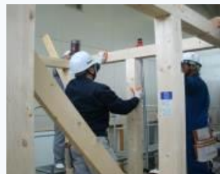
▲ 木造軸組工法による建物組立の実習
