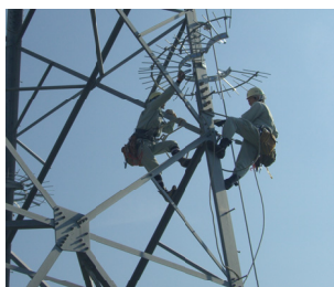
関西電力 SC管内 架線金具修繕工事
