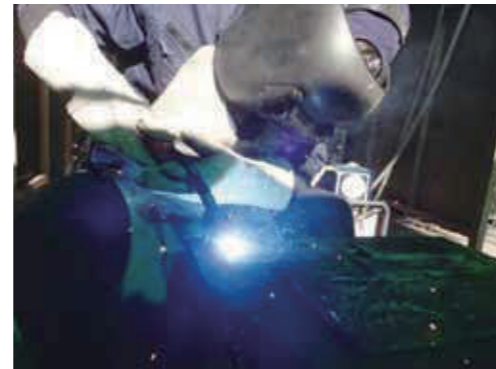
【中板突合せ下向き溶接】
