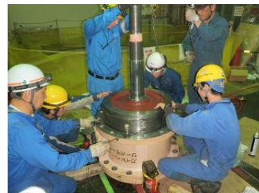
▲水車発電機分解修繕
