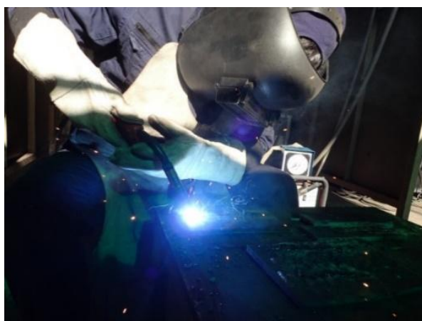
〔中板突合せ下向き溶接〕
