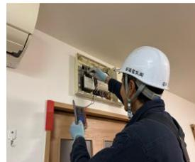
先輩と現場を回っており、指示やアドバイスをもらいながら公共施設である小学校の低圧屋内配線部分の電気工事を行っている。一人で現場を持つ、任されるように技術を身に付けることが目標です。現在は第一種電気工事士の資格取得に向け、技能試験対策を行っているところです。
