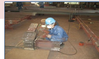
（半自動炭酸ガスアーク溶接作業）
