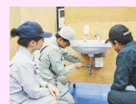
内装施工（壁紙の貼り方）や断熱材の施工方法・知識を学びます。水回りや配管設備について学びます。洗面器の取付や配管の接合方法を学びます。
