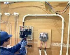
電気工事ではケーブルの施工だけでなく、管に電線を通して施工する工事もあります。金属や樹脂の電線管を加工して様々な電気工事の手法を学びます。
