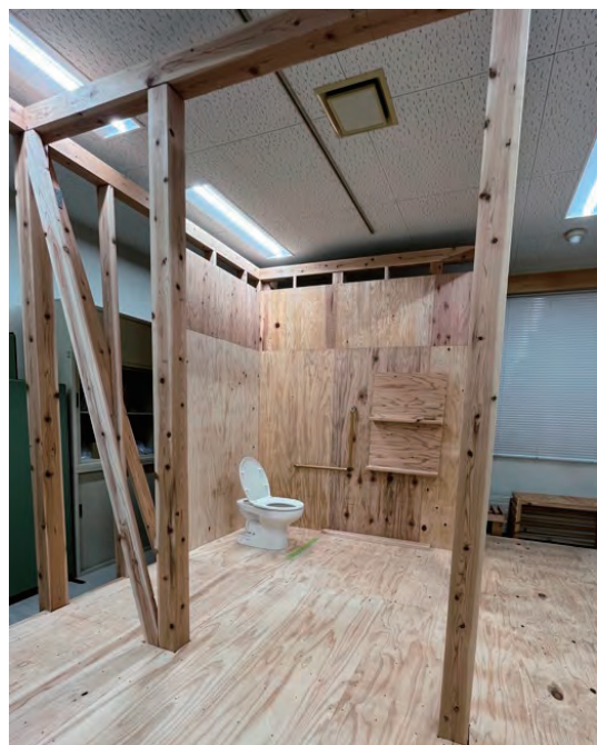
図3 完成したトイレスペース
