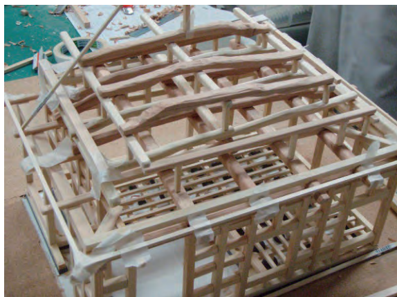
図 4 母屋構造復元模型(牛持梁部分)
