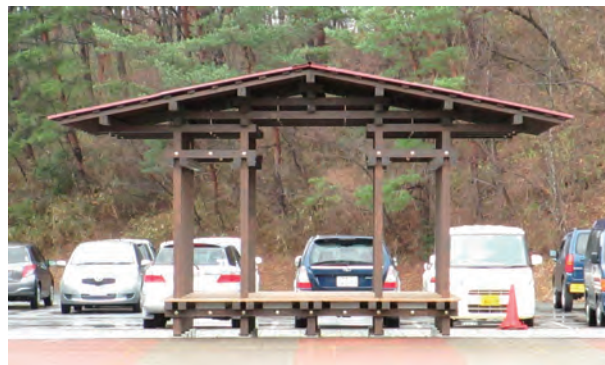
図 3 改修後の休憩所(2013/04/03)
