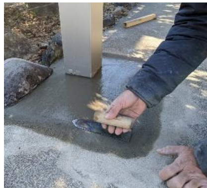
カーポートのコンクリート部分の施工
