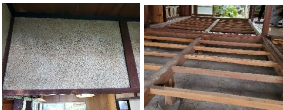
図3 改修前の状況 (左：壁、右：床下)
