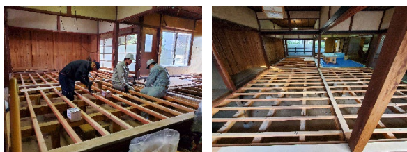
図6 床下地の施工
