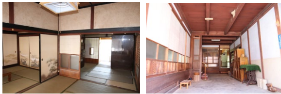
図2 改修前の状況 (左：居間、右：土間)
