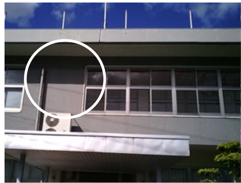
図 11 南側外壁 2 階部分の写真
