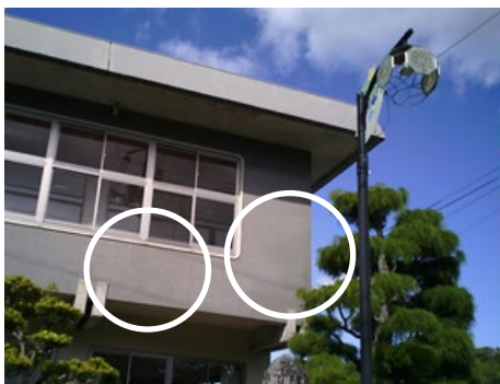
図14 南側外壁2階腰壁部分の画像
