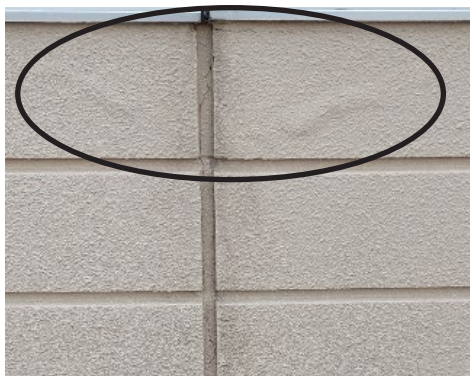
図 9 実験実習棟 1 階東面、外壁写真
