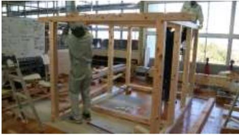
図 18-9 軸組の仮組み
