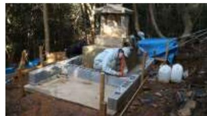
図 17-5 2年目の基礎施工 (基礎完成)
