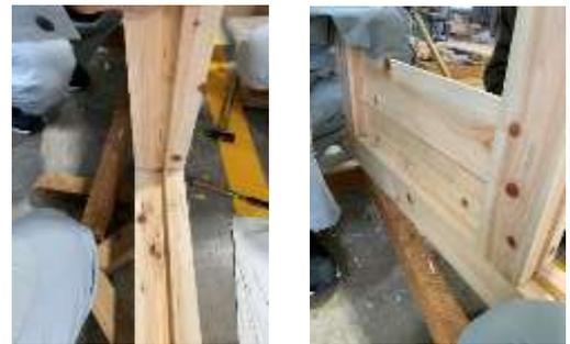
図 18-6 ぬきと羽目板の段取り
