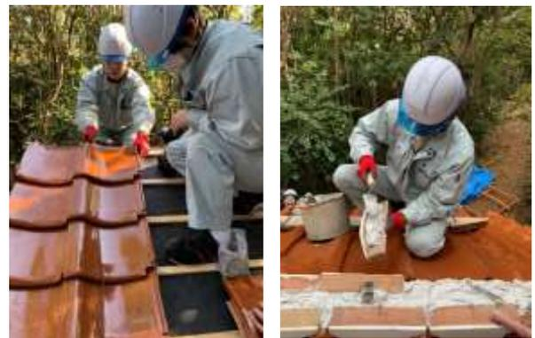
図 19-4 瓦の施工
