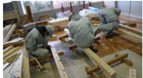
図 18-7 小屋組み材加工の様子
