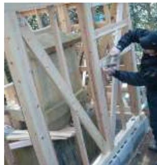
図8 筋交いを用いた構造
