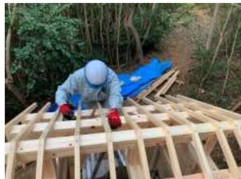
図 19-3 屋根下地の施工
