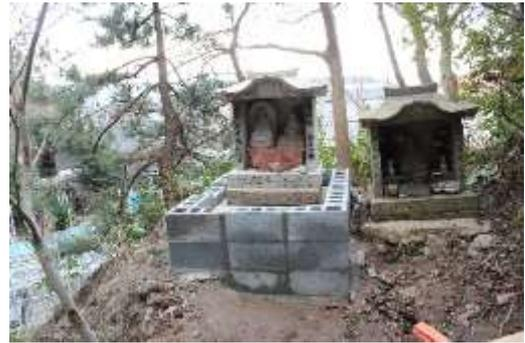
図 16-2 初年度の基礎施工 (完成)
