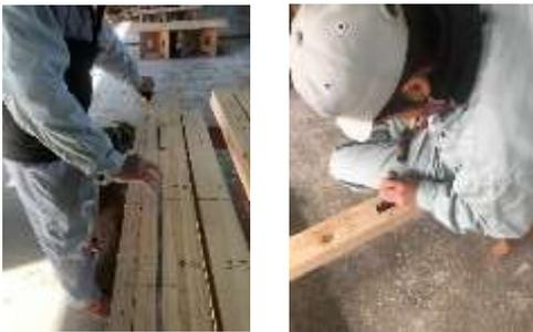
図 18-2 部材の墨付け・加工の様子
