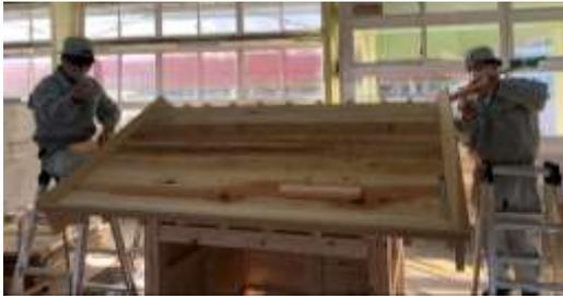
図 18-10 屋根下地材の取り付け
