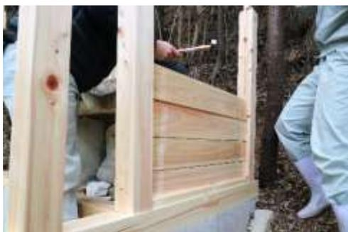
図7 ぬきと羽目板の構造形態
