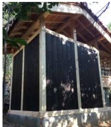
図10 焼き杉材を使用した外壁仕上げ
