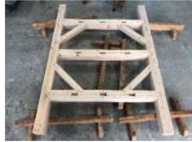
図 18-5 桁・梁の仮組み
