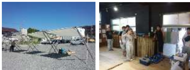
図 3 竹テントと解体作業
