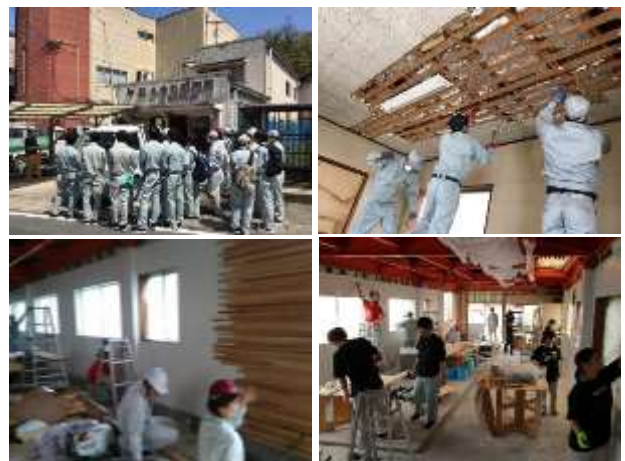
図17 解体作業と仕上げ作業の様子
