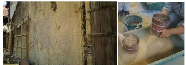
図 18 古民家の土壁
