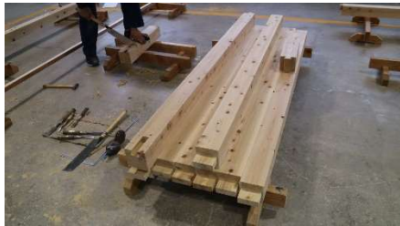
図 7-4 柱の加工
