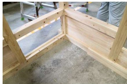
図 7-5 んきと羽目板の施工
