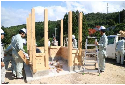
図 8-2 現地での建て方作業
