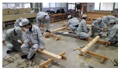
図7-2 土台施工の様子
