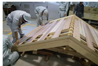
図 7-9 屋根下地の施工
