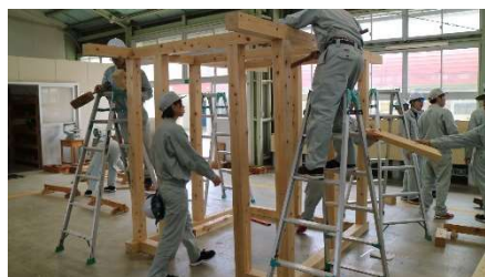
図 7-4 軸組みの仮組み
