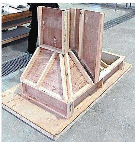
図3 技能検定2級（型枠施工）課題
