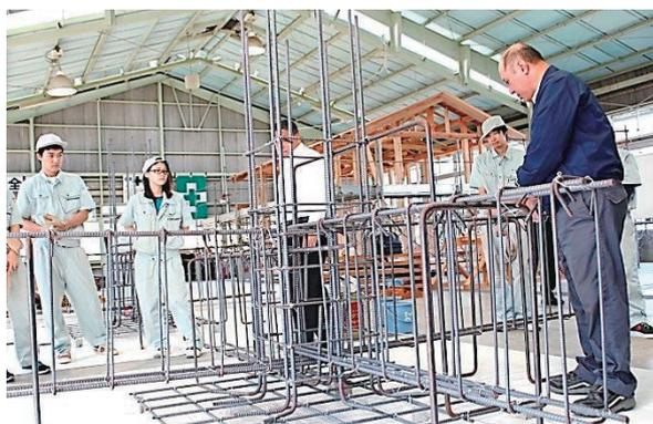
図4 技能検定2級（鉄筋施工）課題
