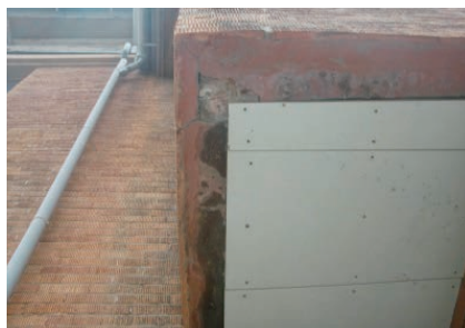
図 4-7 階段室直下の補修箇所（下から）
