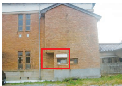
図 4-5 階段室直下の補修箇所
