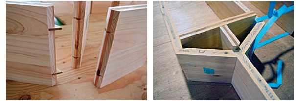
写真7 3方向接合部（左）と接着用治具（右）
