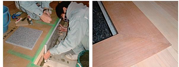
図28 御影石の設置（左）と炉縁の大留（右）
