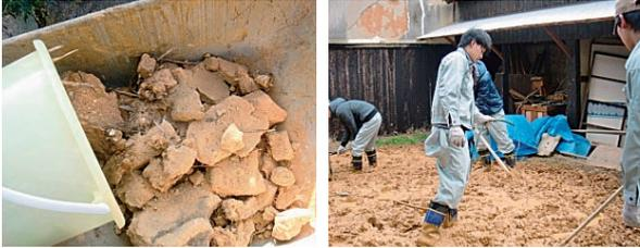
図20 練る前の土の状況(左)と土練り作業の様子(右)
