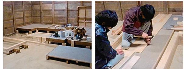
図27 教壇の設置状況（左）と床板張りの様子（右）
