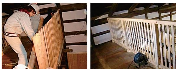
図 35 手摺組立ての様子（左）と完成後の手摺（右）
