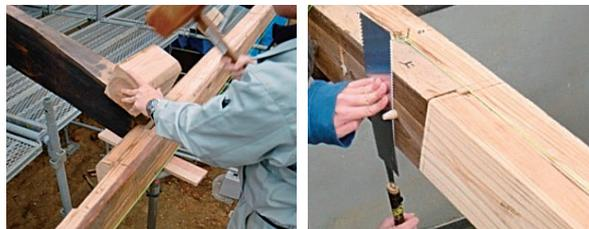
図 16 更新部の桁の組立て (左: 仕口部、右: 継手部)
