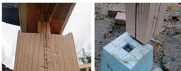
図 17 更新部の柱の組立て (左: 上部、右: 下部)
