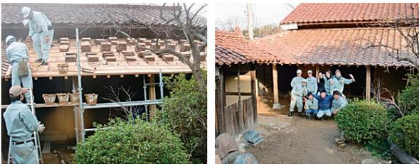
図21 瓦葺き作業の様子(左)と完了後の状況(右)
