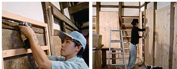
図 32 下地枠の取付け (左) と杉板張り (右) の様子
