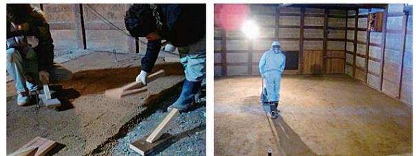
図23 叩き作業(左)と転圧機がけ(右)の様子
