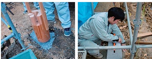
図 15 砂利地業 (左) と礎石設置 (右) の様子
