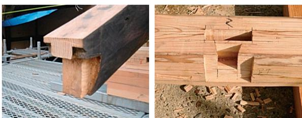
図 14 兜蟻掛け (左: 既存部の梁、右: 更新部の桁)
