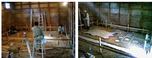
図26 遣り方（左）と捨てコン打ち（右）の様子
