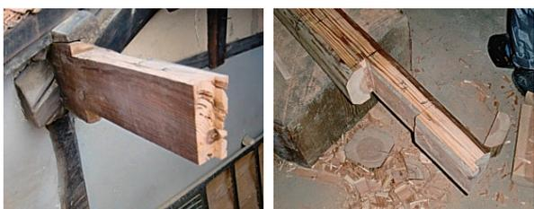
図 13 追掛け大柱継ぎ (左: 既存部材、右: 更新部材)
