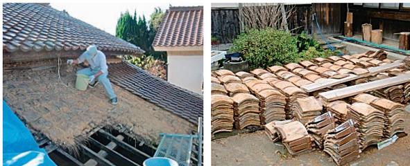
図9 撤去の様子(左)と撤去した瓦(右)
