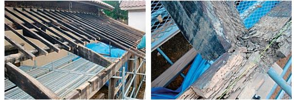
図10 下地撤去後の下屋(左)と蟻害状況(右)
