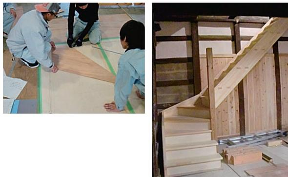
図 33 型板作成の様子 (左) 完成した階段 (右)
