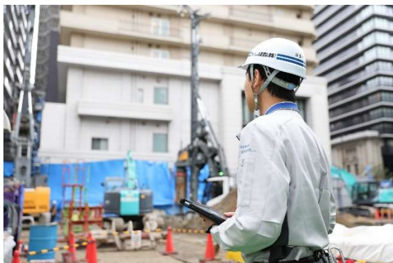
安全が第一。建設現場では一時も気が抜けません
