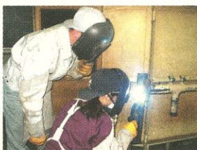
溶接施工も実習でしっかりと習得
