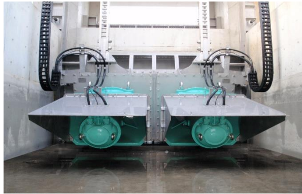
超低水位運転ゲートポンプ（全速全水位運転対応型）
