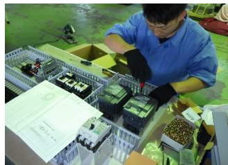
制御盤の組立
