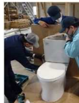
衛生器具の据え付け
