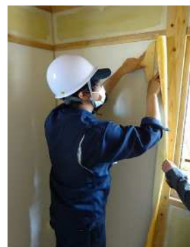
内装施工の一環で行うクロス張り
