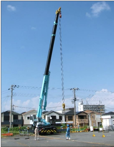
25トン移動式クレーンを用いた実習
