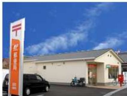
田尻郵便局新築工事
